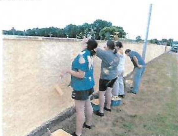
Réfection du mur du cimetière
